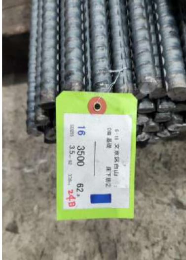
▲現場毎に配色を変えている荷札
