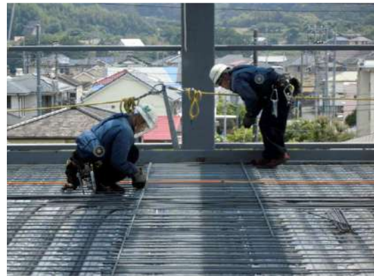
▲商業ビルの施工現場の様子
